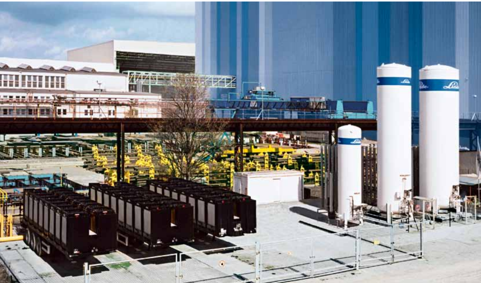
Gasversorgung: 3 Acetylen-trailer und Flüssigtanks für Argon, Kohlendioxid und Sauerstoff
