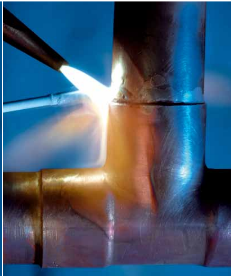
Flammlöten an einer Kupferrohrleitung
