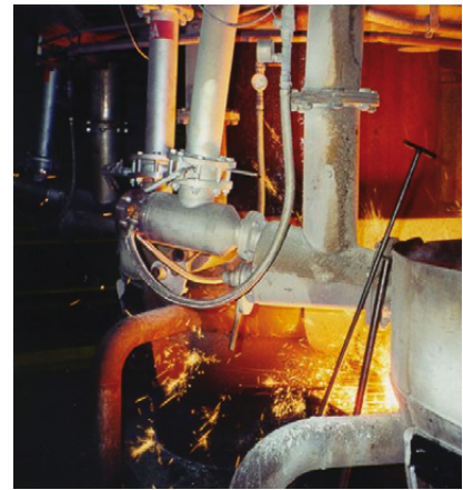
Kupolofen auf TDI-Verfahren umgerüstet
