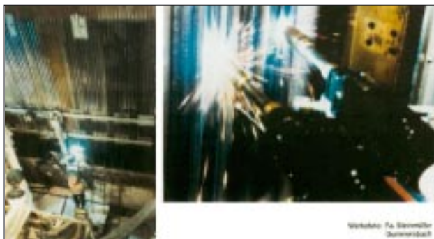
Bild 18 Plattieren von Flossenrohrwänden in Müllverbrennungsanlagen
